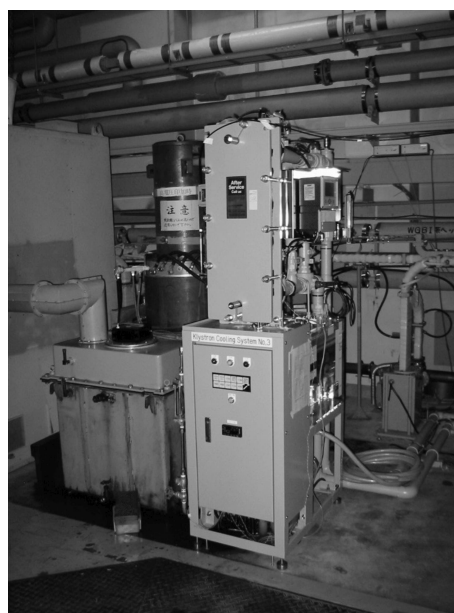
図2 更新後のクライストロン冷却装置
